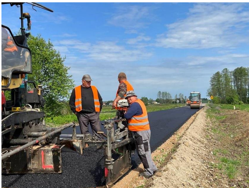
Rozbudowa drogi powiatowej 2059B – Pszczółczyn
