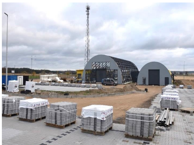
Utwardzanie terenu na placu targowym - budowa
